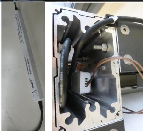
16. Connectez l'alimenteur au contrôleur. Ensuite, placez-le dans le support qui se trouve dans le poteau et placez le contrôleur au-dessus ou à côté (Fig.13). Le câble d'alimentation doit être conduit à travers le capuchon supérieur du poteau ou dans le coin sélectionné de la pergola avec le profil de la poutre, en utilisant les trous d'installation fi 20 réalisés dans les connecteurs (Fig.13).
