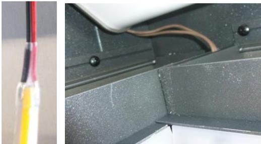
8. Placez les connecteurs de câble avec câbles intégrés aux extrémités de la bande de LED avec connexion d'alimentation. (fig.6 - gauche). Les câbles doivent être insérés dans la rainure de l'embout de gouttière - Fig. 6 à droite (version préparée pour LED) ou placés au bord de l'embout de gouttière (version sans LED). Au-dessus des gouttières du poteau, faites un trou dans un endroit pratique pour insérer les câbles dans le poteau.
